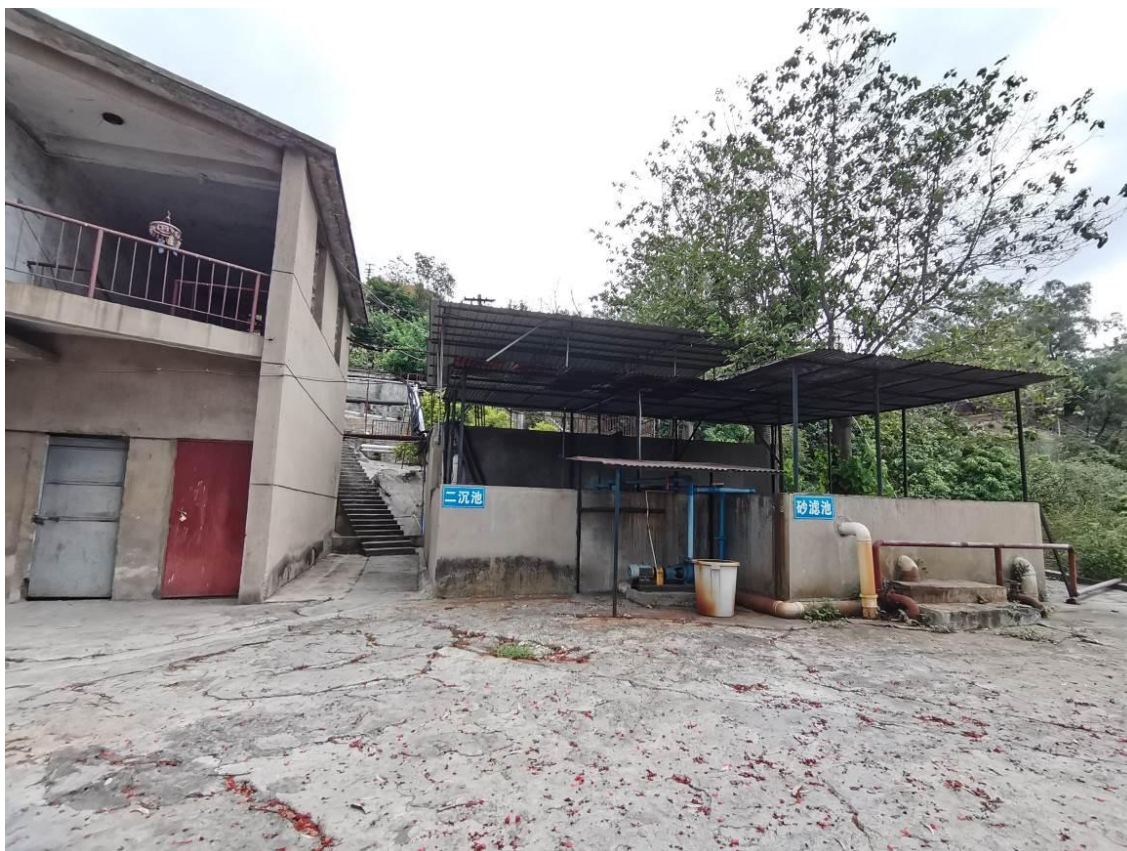
图 3.1-3 现有项目污水处理站现场照片
