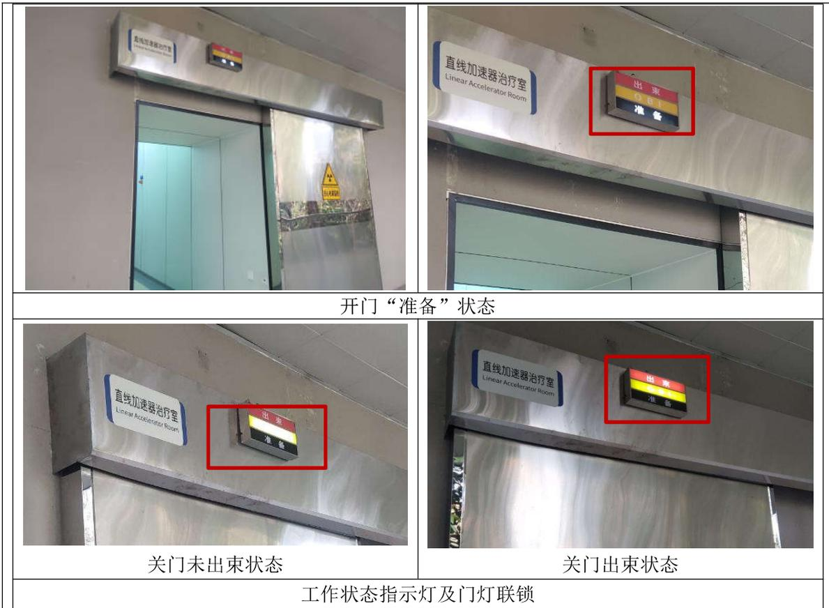
④紧急止动装置和紧急开门按钮：除了加速器治疗床、加速器主机上、控制台上自带的紧急止动按钮外，治疗室四墙面上（4 个）、迷道墙上（1 个）、操作间墙上（1 个）均设置有中文标识的紧急停机开关，误入人员按动紧急停机开关就能使加速器停机；迷道出口处设置中文标识的紧急开门按钮（1 个）。
