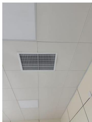
东北角事故排风口
